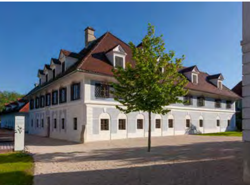
Wiederhergestellte Fassade des Herrenhauses
