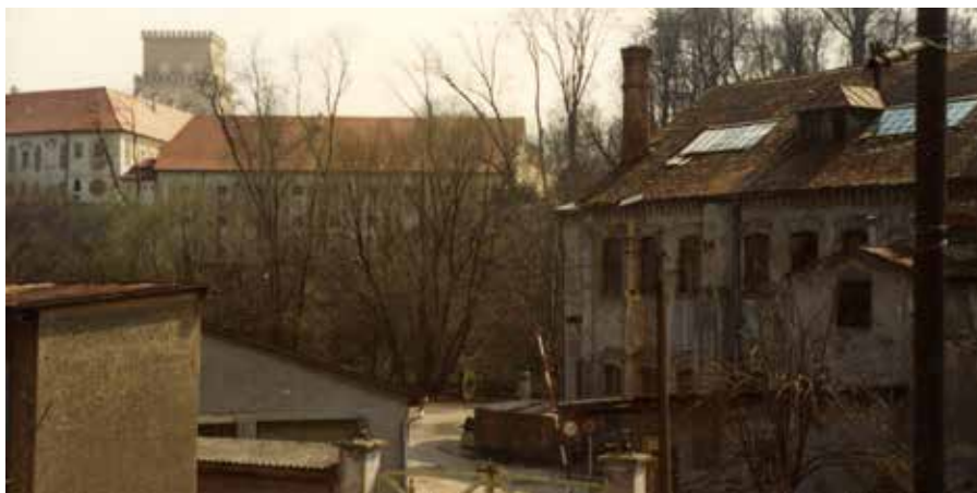
Gebäude vor der Sanierung durch den Verein (Foto: Sammlung Verein Museum Arbeitswelt)
