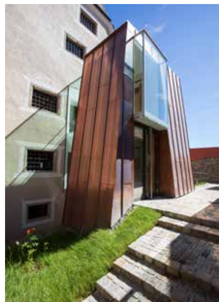
Der mit Kupfer verkleidete Liftturm wurde durch einen Glasgang vom Gebäude abgerückt, um die Sgraffito-Fassade so unberührt wie möglich zu belassen. (Foto: Bundesdenkmalamt, Irene Hofer)
