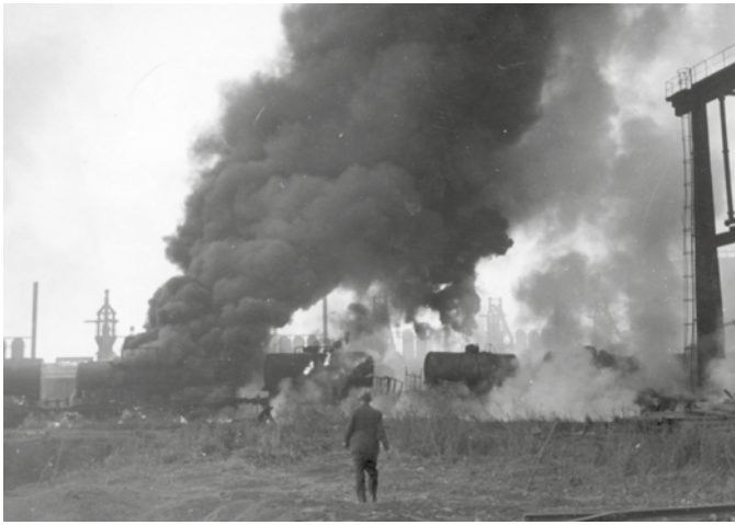
Brennende Teertanks am Gelände der „Reichswerke Hermann Göring“ nach einem Luftangriff (Quelle: Geschichte Club Stahl)
