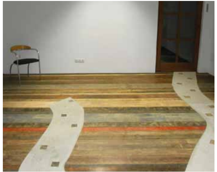
Lederfußboden aus gebrauchten Treibriemen im neuen Veranstaltungsraum (Foto: Sattlermuseum)
